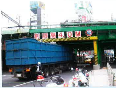
二葉橋ガード 外堀通り
