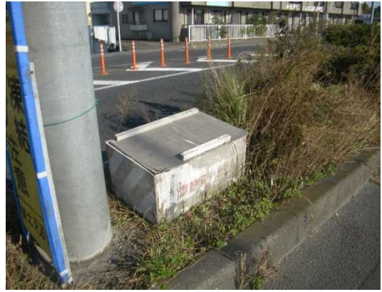
砂箱の設置事例②(群馬県内:国道18号)
