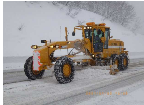
国道18号野尻地区での除雪状況(R3年1月)
