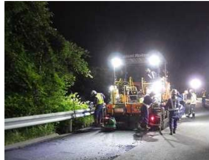
舗装補修工事 作業状況
