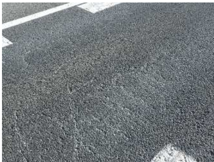
舗装損傷状況
