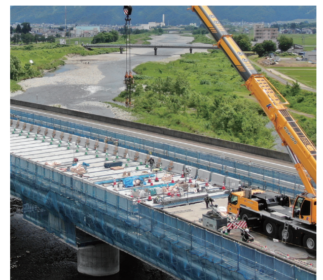
工事実施状況
